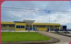
Hospital Geral Público Castelo dos Sonhos, Altamira (PA)
