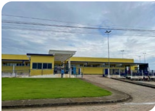
Hospital Geral Público Castelo dos Sonhos (HGPCS)
