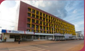
Hospital Regional Público do Tapajós, Itaituba (PA)
